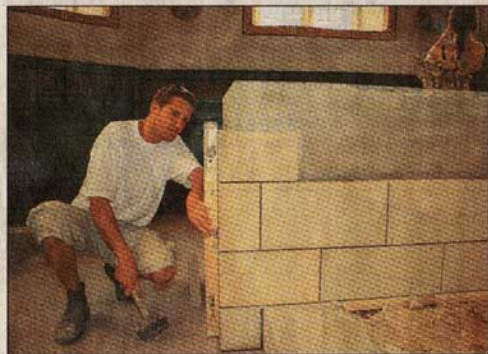
Claas Baranowski beim Anbringen der Sandsteinblenden.
